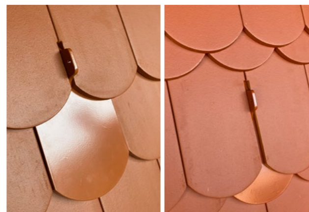
(Bild 2, links Doppeldeckung, rechts Kronendeckung)
